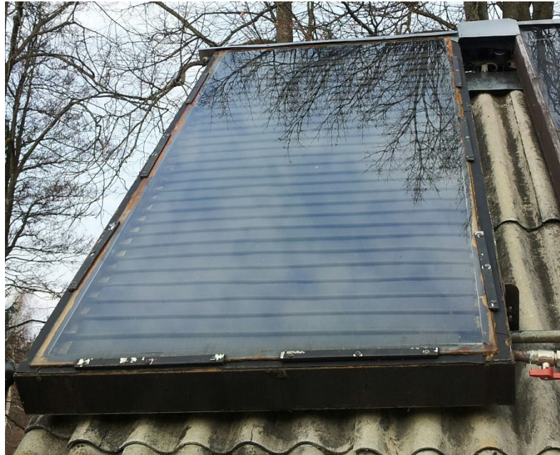
Fig. 1. Flat-plate solar collector
